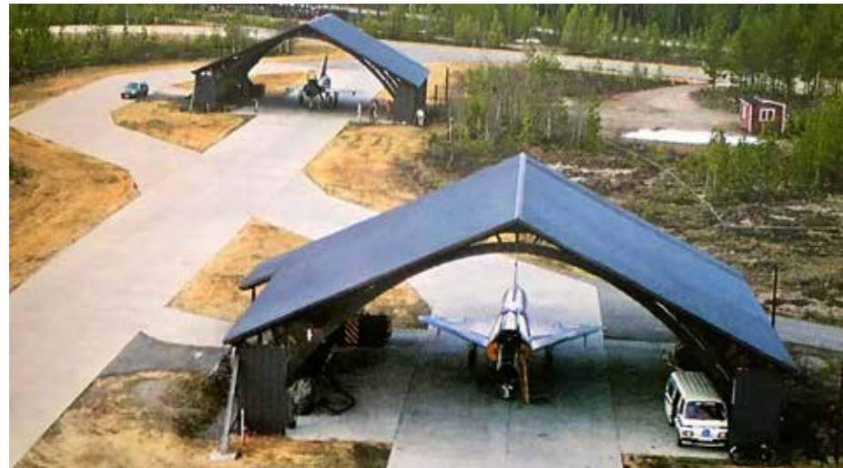
Unterstände für die Erstellung der Flugbereitschaft
