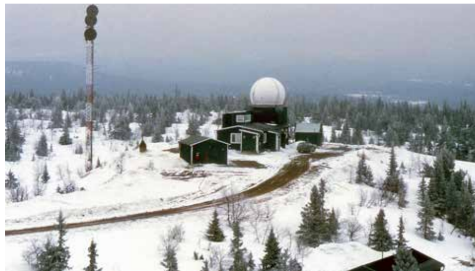
Eines der beiden Zielverfolgungsradars und Telemetrie-Sender in der Testrange. Übertragungen zur Zentrale in Echtzeit
